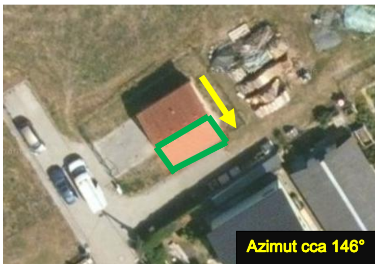
Obrázek 24: Vodárna – střecha pro FVE
